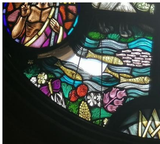
Figs. 26-27. Abombamiento de la vidriera de Daniel y caída de vidrios del rosetón. Foto: Isaac Baquero.
