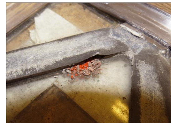
Fig. 10. La presencia de rojo de plomo en la composición de las masillas es fácilmente reconocible y supone un gran riesgo para la salud. Foto: Fernando Cortés Pizano/ Dean and Chapter of Canterbury Cathedral.
