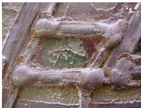
Fig. 11. Marcas de abrasión sobre las soldaduras y los plomos de una vidriera, como resultado de su limpieza con cepillos excesivamente duros. Foto: Fernando Cortés Pizano/ Dean and Chapter of Lincoln Cathedral .
