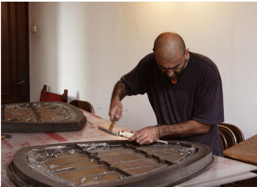
Fig. 15. Extracción de paneles de vidriera mediante martillo y formón. Foto: Xavier Grau Montserrat.
