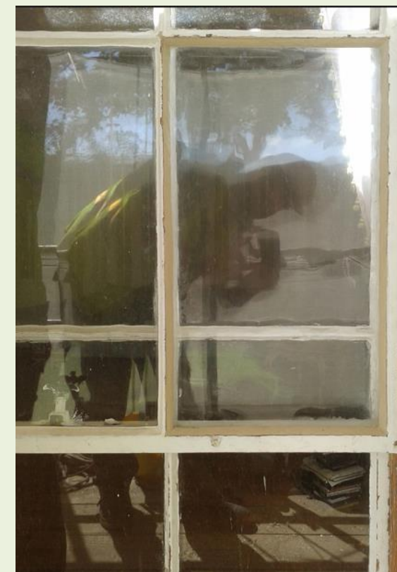
Fig. 4. Montaje de vidrios mediante puntas de acero y sellado con masilla. Fotos: Fernando Cortés Pizano / Dean and Chapter of Lincoln Cathedral .
