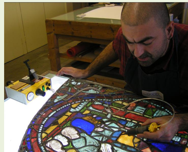
Fig. 14. Aplicación manual de la masilla mediante jeringuilla de aire comprimido. Foto: Tom Küpper/ Dean and Chapter of Lincoln Cathedral .
