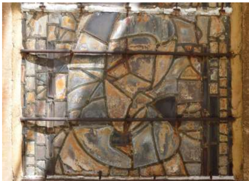
Fig. 3. Panel del ventanal S-XIV antes de su restauración donde se aprecian las barras de rigidización (2025). Foto: Mariano Díez Sáenz de Miera.
