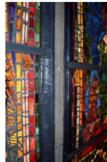
Fig. 24. Paneles de vidrieras del ventanal S-XV ya restaurados y colocados en su lugar, donde se puede observar los plomos laterales adaptados a los abocinados de fábrica (2024) (Fragmento). Foto: Jorge Diez García-Olalla.
