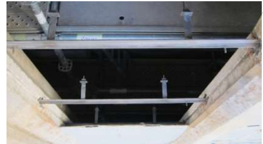
Fig. 18. Perfil en «T» donde se aprecian por el interior las lengüetas de apoyo de los paneles de vidrieras (2022). Foto: Jorge Diez García-Olalla.
