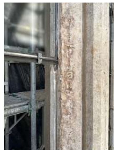
Fig. 20. Panel de vidrio de protección ya colocado en el lugar que antes se encontraba la vidriera (2024). Foto: Jorge Diez García-Olalla.
