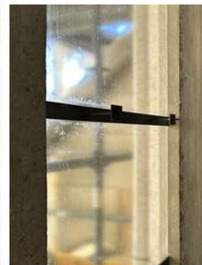
Fig. 21. Paneles del vidrio de protección ya colocados y retacados con mortero de cal y arena (2024) (Fragmento). Foto: Jorge Diez García-Olalla.
