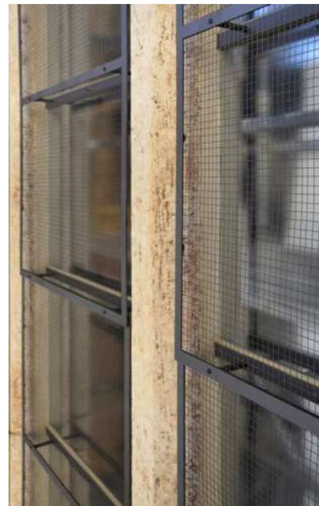
Fig. 26. Mallas de protección colocadas tras disponerse los vidrios de protección en el ventanal N-XV (2024) (Fragmento). Foto: Jorge Díez García-Olalla.
