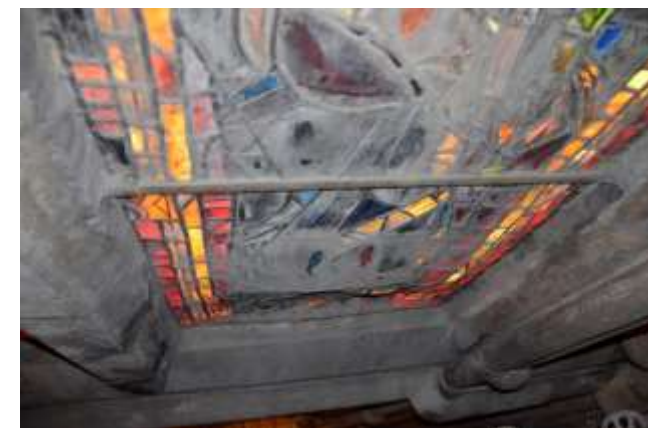
Fig. 11. Paneles del ventanal S-XV vistos desde el interior, donde se observan capas de suciedad adheridas en los vidrios (2022). Foto: Jorge Diez García-Olalla.
