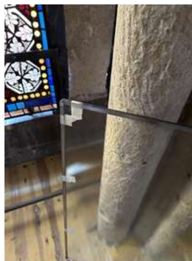
Fig. 19. Panel de vidrio de protección con la tira de plomo ya dispuesta a lo largo de su perímetro (2024) (Fragmento). Foto: Jorge Diez García-Olalla.
