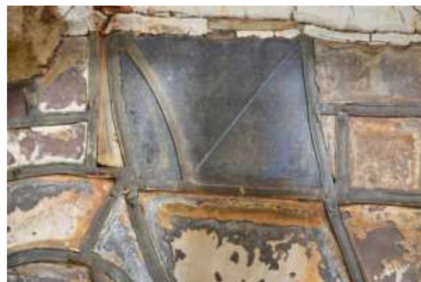
Fig. 13. Detalle de un panel del ventanal S-XV en el que se aprecia fracturado uno de los vidrios (2022). Foto: Jorge Diez García-Olalla.
