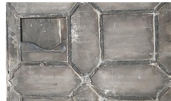
Fig. 3. Antigua restauración en la que un fragmento de latón cubre la laguna. Foto: Bernabé
