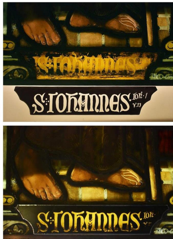
Fig. 18. Alemania, Werningerode, Schlosskirche. Fotos: Glasmalerei Peters, Paderborn. Ejemplo de doblaje de un vidrio con pinturas parcialmente desaparecidas
