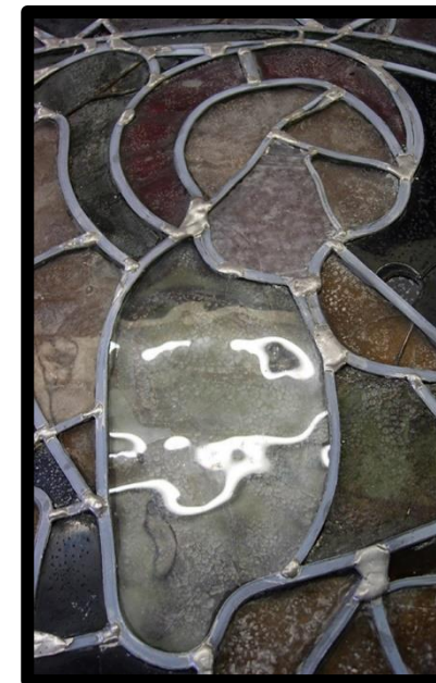
Fig. 11. Inglaterra, Lincoln, Catedral. Dean's Eye. Foto: Fernando Cortés Pizano. Detalle de un vidrio de doblaje termoformado situado por la cara exterior de un vidrio de principios del siglo XIII
