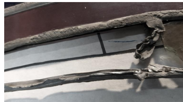
Fig. 1. Bilbao, Iglesia de San José. Foto: Bernabé. Detalle de la red de plomos de una vidriera
