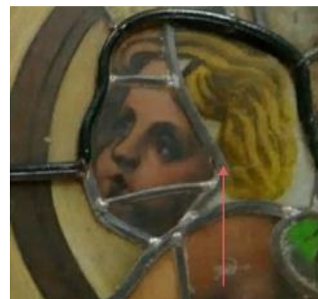
Fig. 9. Impronta de pintura negra de las varillas de intervenciones pasadas. Panel 44
