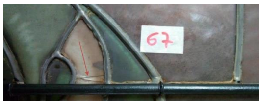
Fig. 29. Detalle de una fractura en el vidrio
