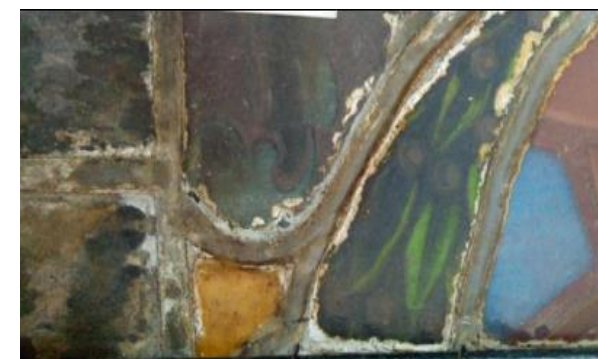
Fig. 6. Detalle de eflorescencias, Panel 5
