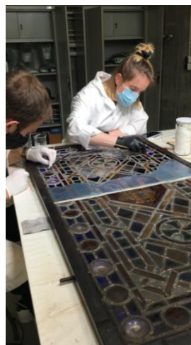
Limpieza de los depósitos más incrustados mediante soluciones tampón y soluciones tampón gelificadas Foto: Silvia Marín
