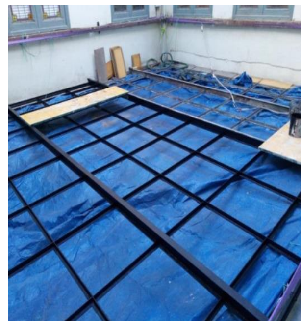
Fig. 26. Estructura sustentante en proceso de intervención.
