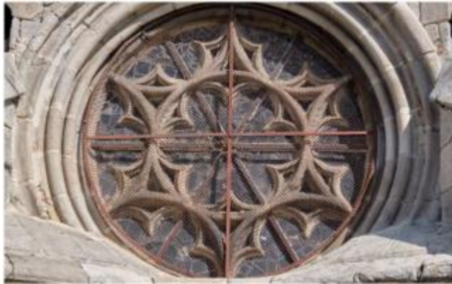
Barcelona, Catedral. Restauración del cimborio y de los rosetones de la nave.
