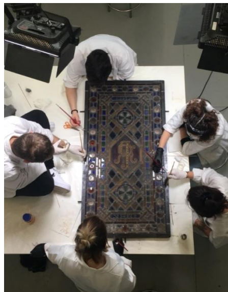
Alumnos trabajando sobre una vidriera de la Catedral de Solsona. Limpieza mecánica de depósitos superficiales Foto: Silvia Marín
