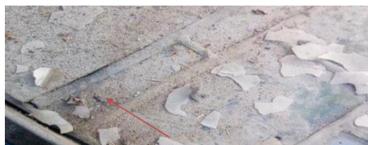
Fig. 30. Detalle de pieza de vidrio fuera del canal del plomo y de los residuos de plástico
