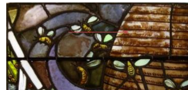
Fig. 11. Grisalla parcialmente desprendida por mala técnica de ejecución. Panel 22
