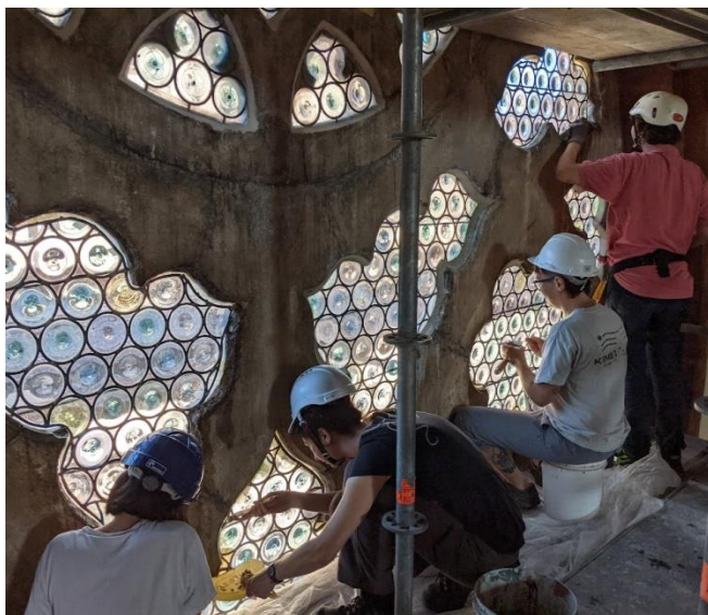
Grupo de restauradores y conservadores que colaboran con Vetreteria d'Arte Gamberini en la reinstalación de una vidriera de la Basílica di San Petronio en Bologna, después de la restauración realizada en el taller
