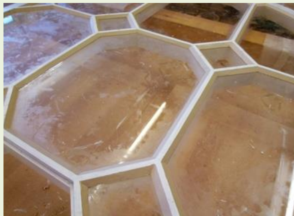
Fig. 4. Montaje de vidrios mediante puntas de acero y sellado con masilla. Fotos: Fernando Cortés Pizano / Dean and Chapter of Lincoln Cathedral .
