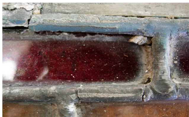
Fig. 9. Deterioro y pérdida de la masilla de la red de plomo. Foto: Fernando Cortés Pizano.
