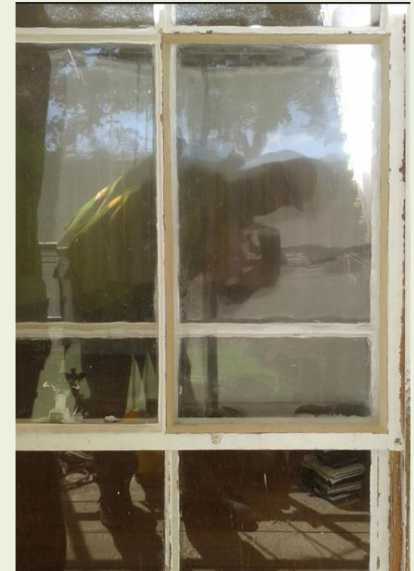
Fig. 4. Montaje de vidrios mediante puntas de acero y sellado con masilla. Fotos: Fernando Cortés Pizano / Dean and Chapter of Lincoln Cathedral .
