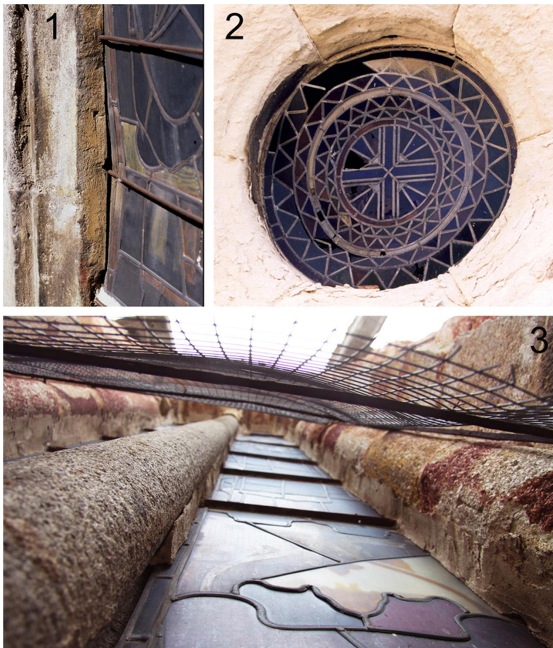
Fig. 14. La pérdida gradual de adherencia del mortero puede ocasionar su desprendimiento, así como movimientos en el panel de la vidriera, rotura de nudos de sujeción de las varillas de refuerzo y consiguiente desprendimiento de estas, abombamiento de paneles, pérdida de vidrios, etc. Foto 1: Basílica dels Sants Màrtirs Just i Pastor (Barcelona). Foto 2: Cementerio de Poble Nou (Barcelona). Foto 3: Catedral de Ávila. Imágenes: Fernando Cortés Pizano.
