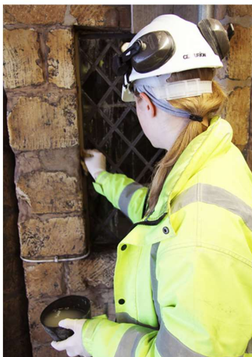
Fig. 11. Materiales y herramientas usados para alisar y dar textura al mortero y limpiar la piedra. Foto superior: brochas y paletinas. Imagen: Fernando Cortés Pizano. Foto inferior: esponja humedecida. Imagen: Fernando Cortés Pizano/Chapter of Lincoln Cathedral.
