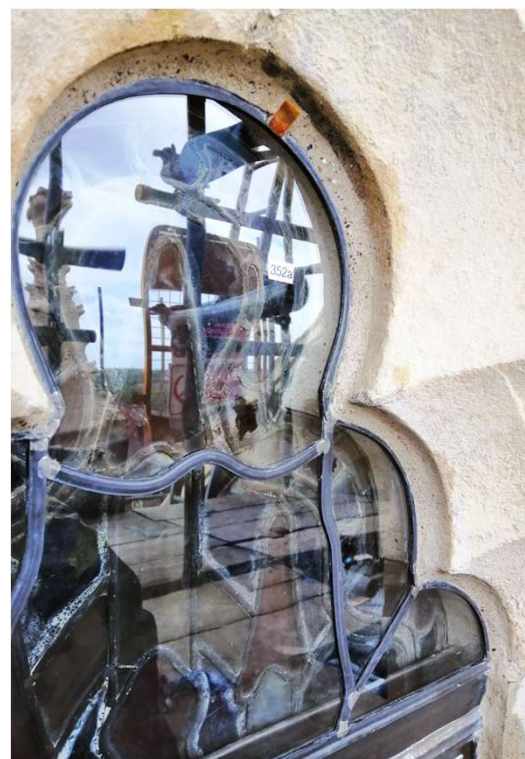
Fig. 10. Proceso de aplicación del mortero en un panel de vidriera, evitando que sobresalga excesivamente del surco, rejuntando sobre plomo y evitando la creación de cuñas de mortero muy gruesas. Imagen: Fernando Cortés Pizano/Chapter of Canterbury Cathedral.
