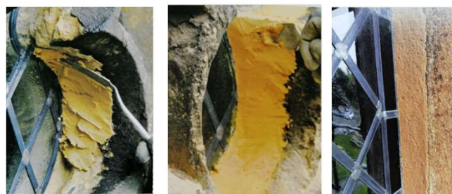
Fig. 3. Uso de arenas o pigmentos para alterar el color del mortero y adaptarlo al de la fábrica circundante. Imágen lado izquierdo: Mikel Bullen/Chapter of Lincoln Cathedral. Imágenes lado derecho: Holy Well Glass.
