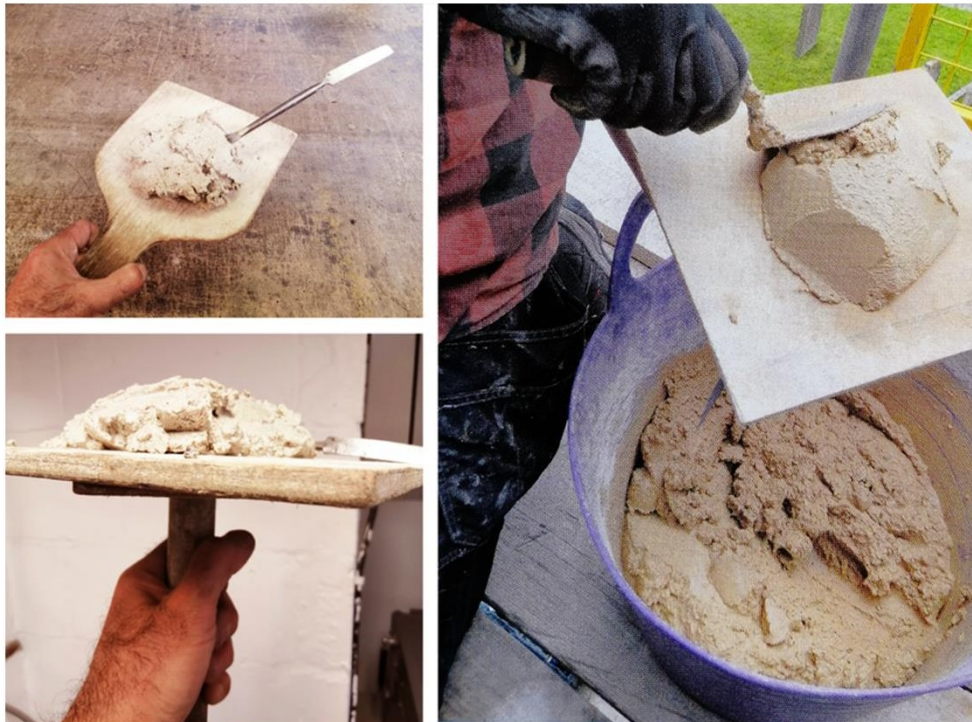
Fig. 6. Herramientas y materiales utilizados para la depositar y sostener el mortero durante el proceso de rejuntado de una vidriera. Imágenes lado izquierdo: Fernando Cortés Pizano. Imágenes lado derecho: Holy Well Glass.
