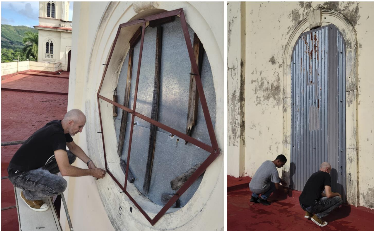
Fig. 8. Santiago de Cuba, Santuario Nacional de la Virgen de la Caridad de El Cobre. Trabajos de desmonte de estructuras y paño de vitral existente.
