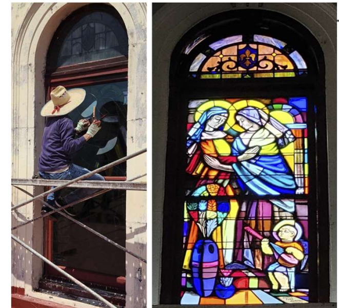
Fig. 19. Santiago de Cuba, Santuario Nacional de la Virgen de la Caridad de El Cobre. Colocación del vitral "La Visitación a Isabel".
