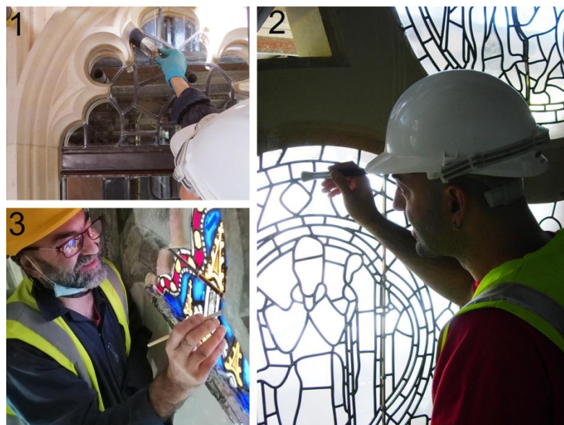
Fig. 12. Operación final de limpieza del vidrio, plomo y piedra mediante brochas, pinceles y punzones de madera. Imágenes 1 y 3: Chapter of Canterbury Cathedral. Imagen 2: Mike Bullen/Chapter of Lincoln Cathedral.
