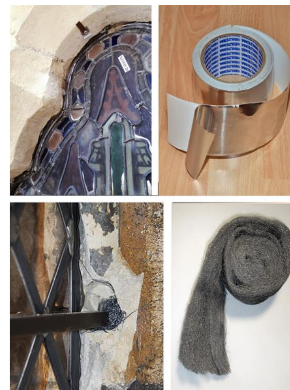
Fig. 4. Operaciones previas al proceso de rejuntado de paneles de vidriera con mortero: fijar los paneles y las varillas de refuerzo mediante cuñas de lana de plomo, cinta de aluminio adhesiva, madera, plástico, etc. Imágenes lado izquierdo: Fernando Cortés Pizano. Imágenes lado derecho: Wikidata (superior) y Wikipedia (inferior).
