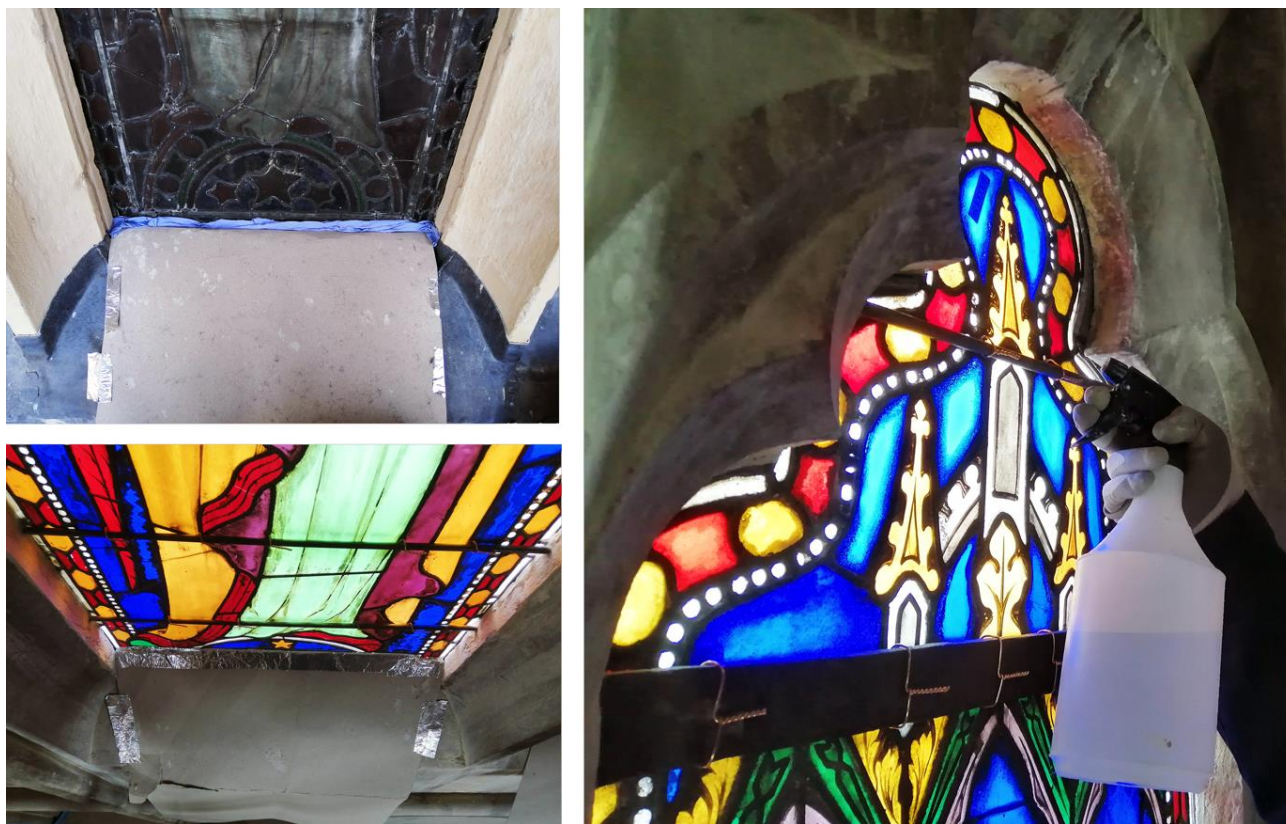
Fig. 5. Operaciones previas al proceso de rejuntado con mortero de los paneles de una vidriera: proteger la base de la vidriera por ambas caras y humedecer con agua las zonas donde se va a aplicar el mortero. Imágenes: Fernando Cortés Pizano/Chapter of Canterbury Cathedral.
